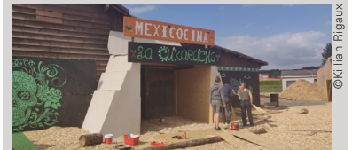
Construction du Trophée de la Venoge à La Sarraz
