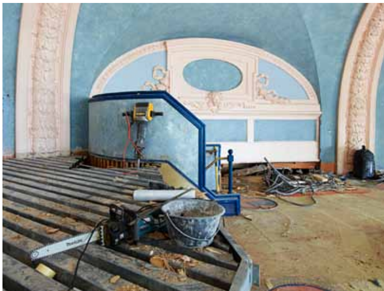
Au début des travaux.
